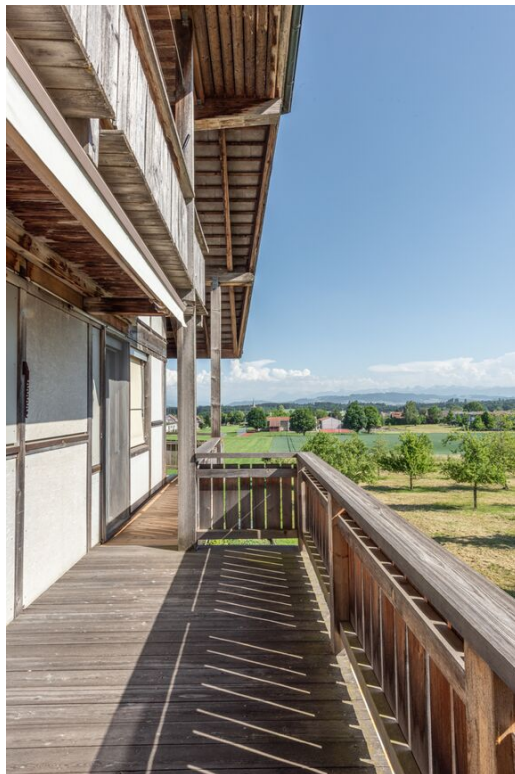
Bakon Westseite und um die Ecke Süd, total 16 m2.
