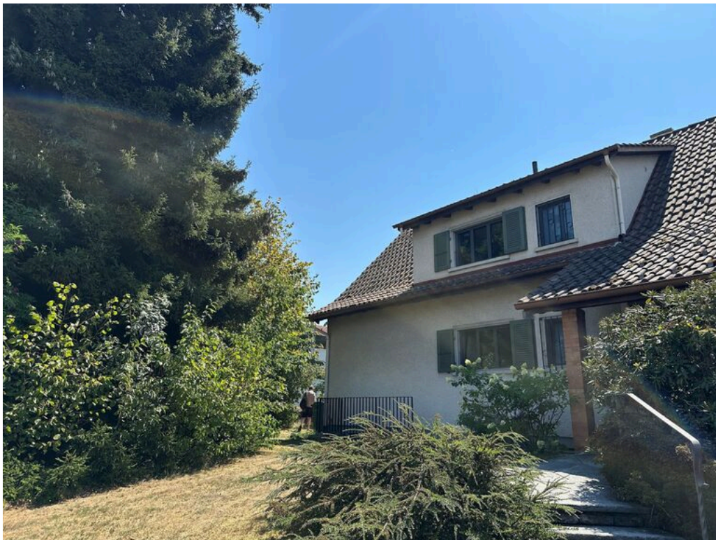
Nordseite: Zugang über den Bach.
