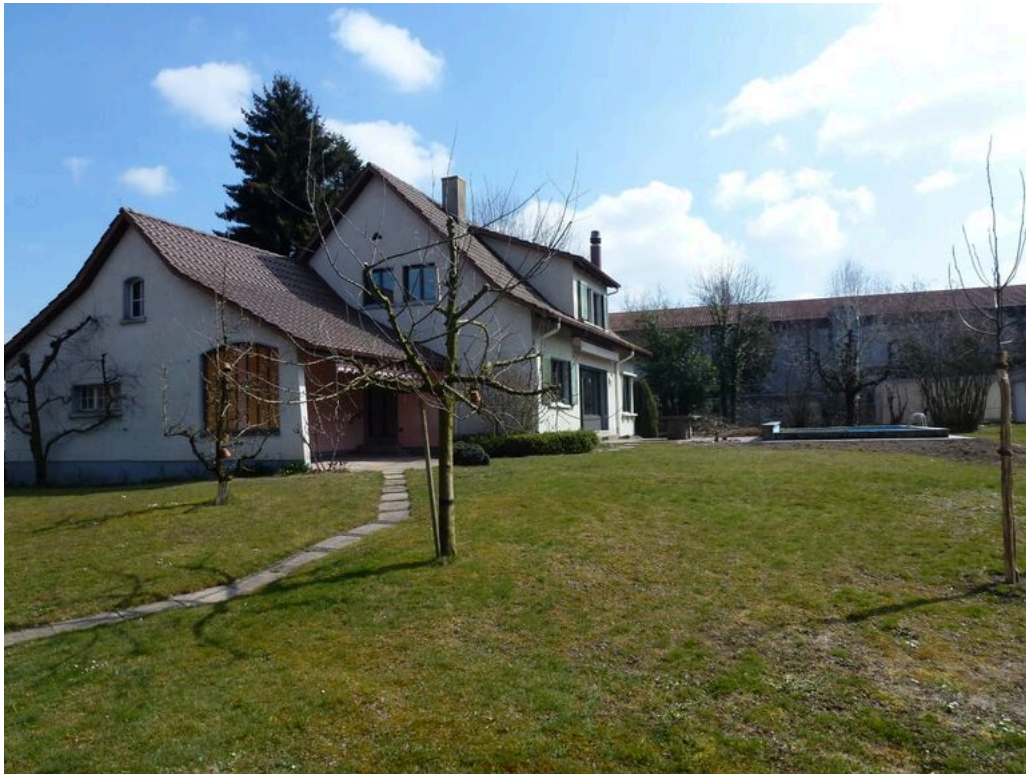
Westfassade: Gartensitzplatz gedeckt (Aufnahme nach Renovation 2016).
