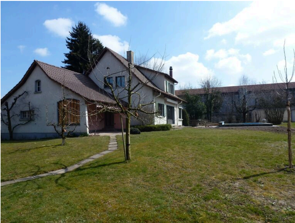
Westfassade: Gartensitzplatz gedeckt (Aufnahme nach Renovation 2016).
