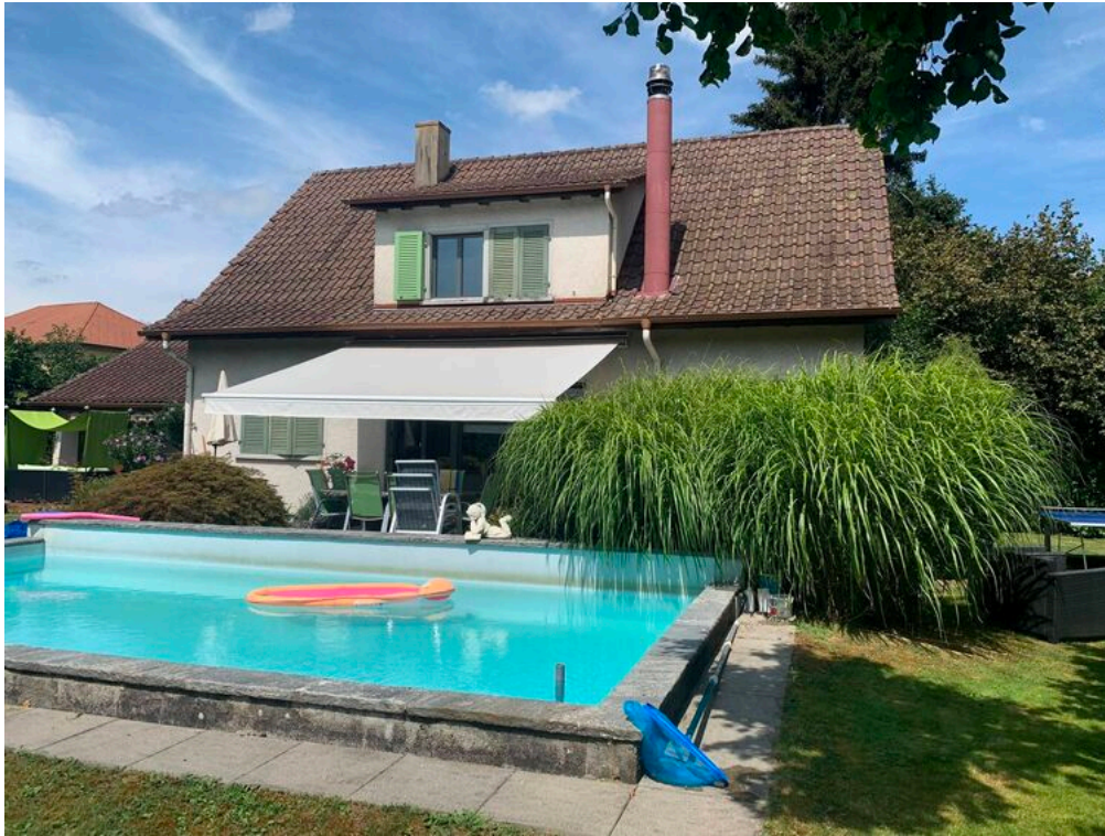
Das Schwimmbad hat eine neue Technik (seit 2016).
