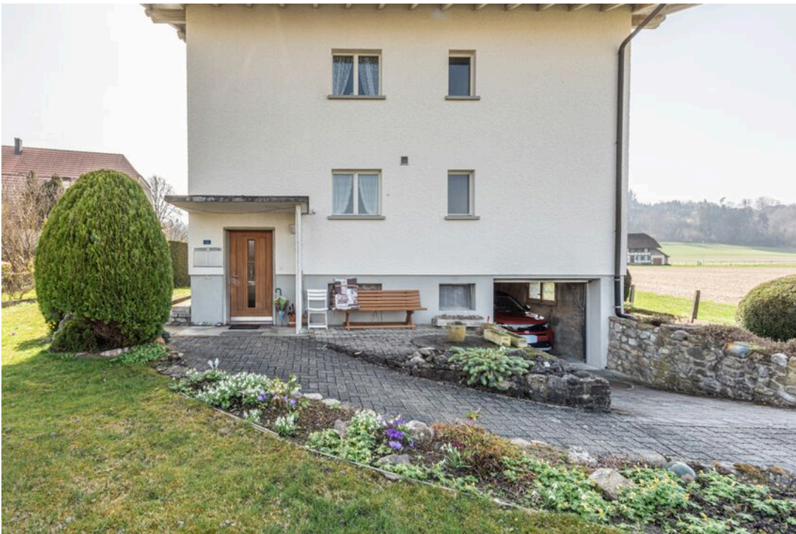
Nordseite, Eingang, Garage und Parkplatz.
