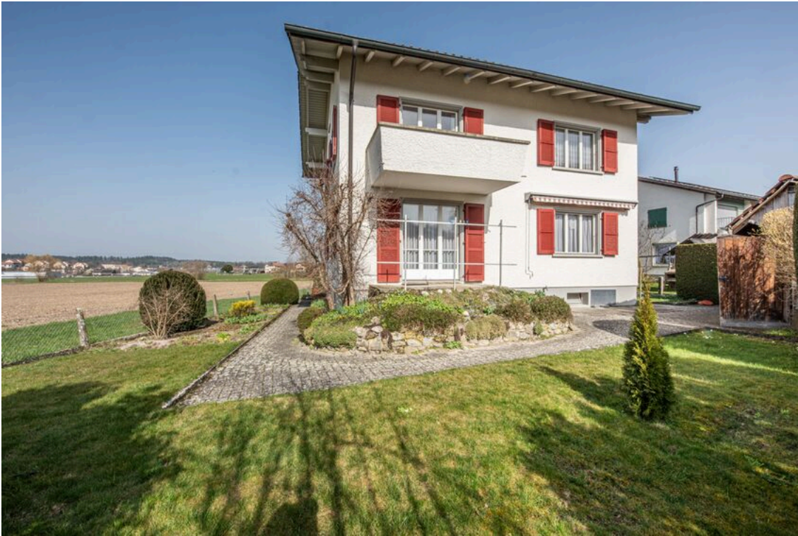
Südfassade, Gartensitzplatz und Balkon.
